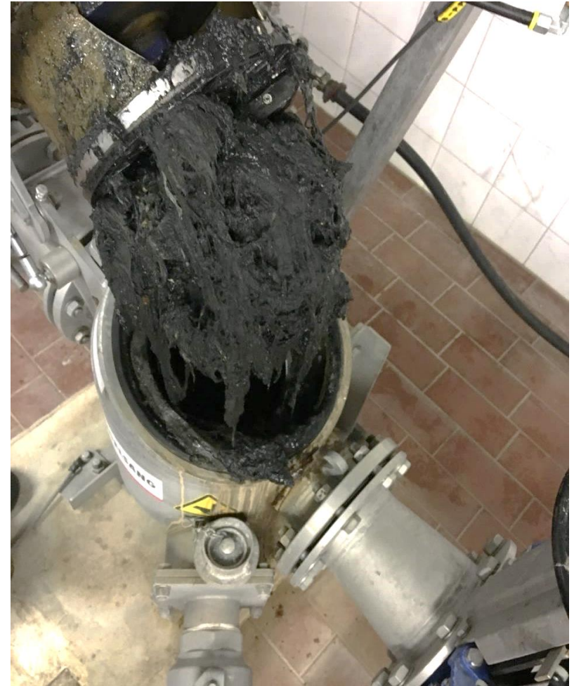
Bild Stadtentwässerung Köln
