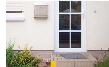
**1** Das Wasser kann über Türen eindringen. Dies kann z. B. durch erhöhte Hauseingänge mit **Stufen** verhindert werden.
