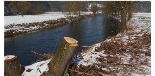
Die Fällung zahlreicher Bäume - nur besonders große Exemplare sollen stehen bleiben - ist Teil des Rückbaus der Uferbefestigung. Der Aggerverband hat dafür eine Ausnahmegenehmigung erhalten.
